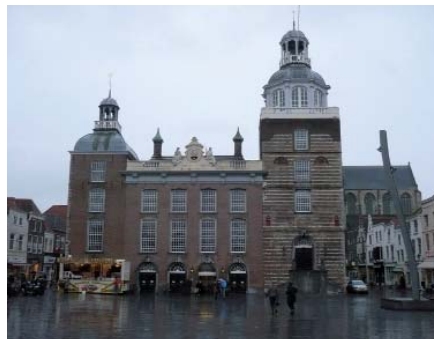
Stadhuis en Grote Kerk gezien vanaf de Oprit
