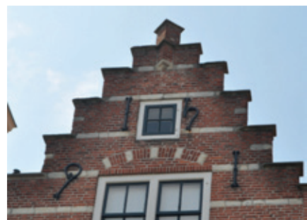
▲ Foto 19 - De muurankers in dit pand vormen een jaartal
