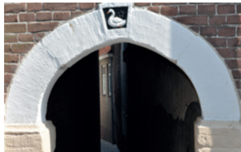
Foto 44 – gevelboogje in de Koningstraat, dat de ingang van het Vuilstraatje markeert.
