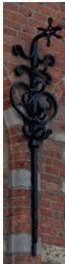
▲ Foto 20 - Nog een fraai muuranker van dit pand
