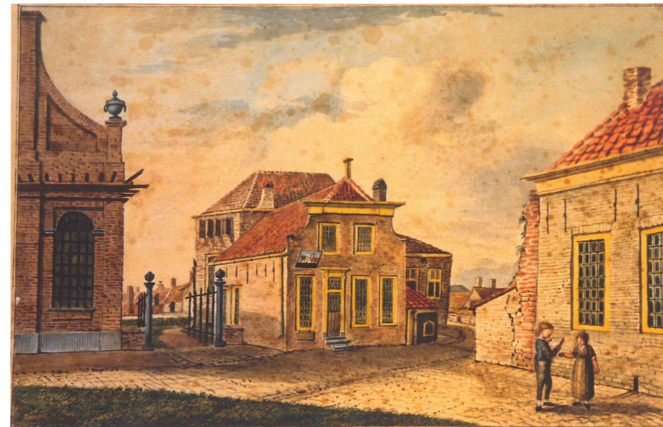
Slot Oostende gezien vanaf de Singelstraat, met centraal de uit het midden van de 18de-eeuw daterende herberg met daarachter de kasteeltoren. Links bevindt zich de rooms-katholieke kerk uit de periode 1815-1906. In de verte waar het terrein afloopt bevinden zich de achterhuizen van de Wijngaardstraat. Aquarel door A. Brandt, 1819. HMDB.
