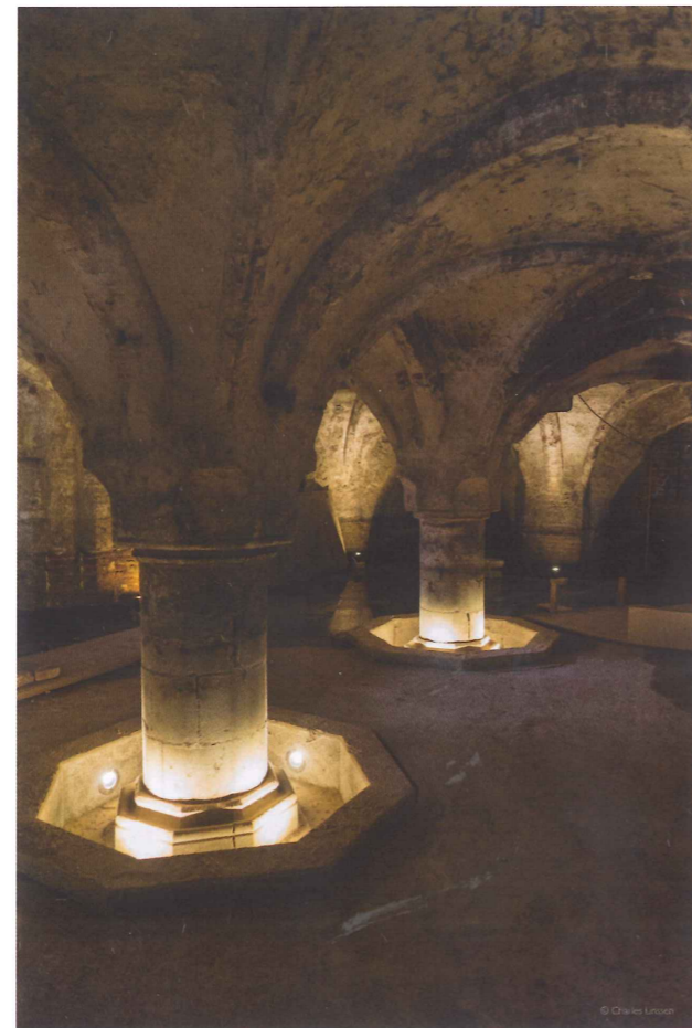
Keldergewelf Slot Oostende
