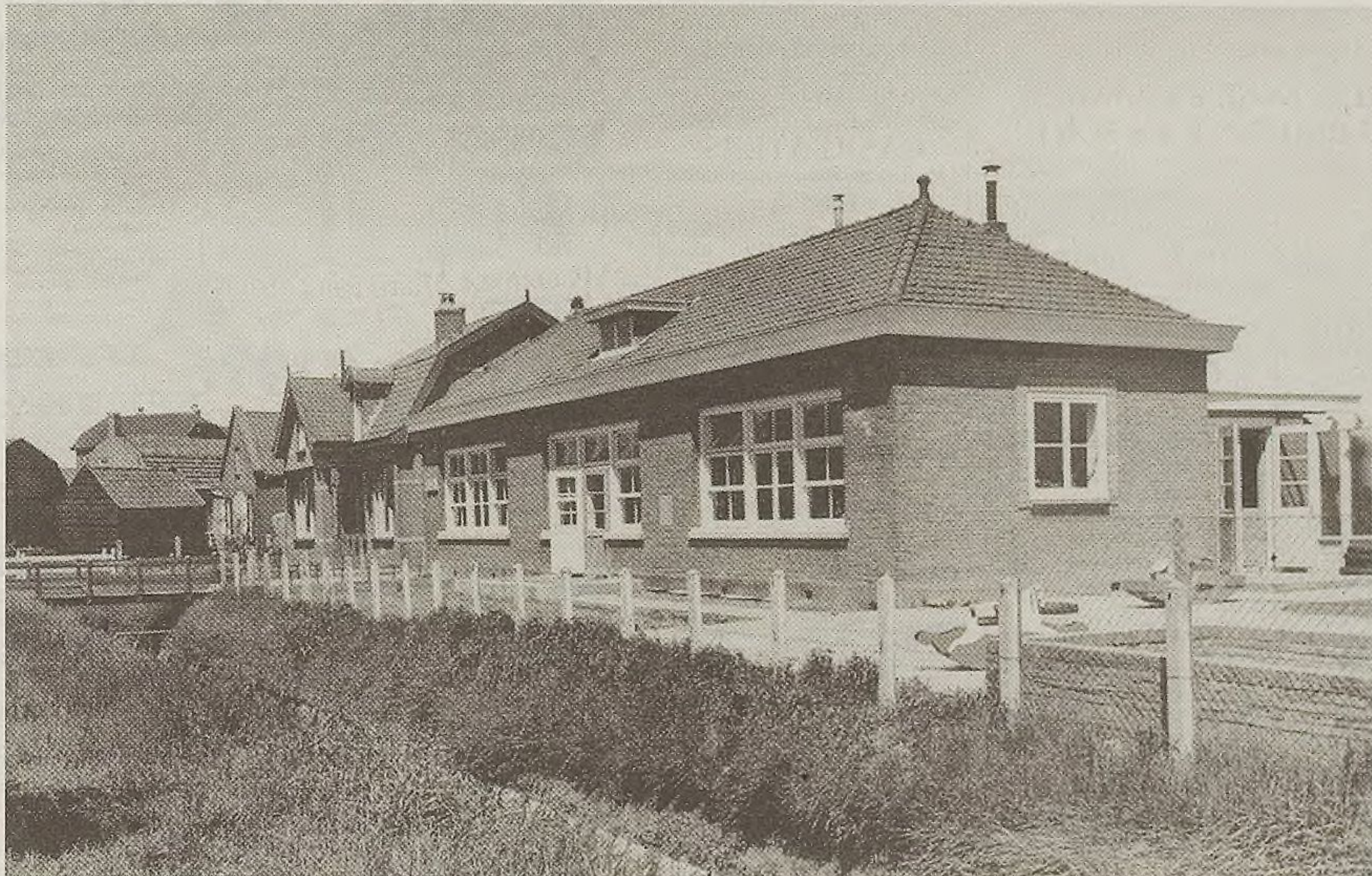
Het eerste schooltje gebouwd voor het uitgebreid lager onderwijs in Kortgene. Later deed het dienst als kleuterschool. Daarna werd het verbouwd tot een aantal woningen. foto gemeente Noord-Beveland.
