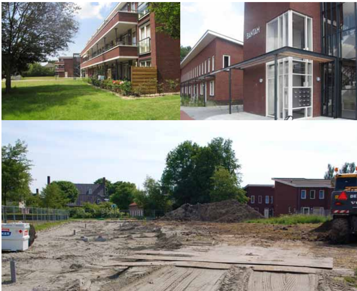
De nieuwe toegangsweg Zevenbladhof wordt aangelegd
