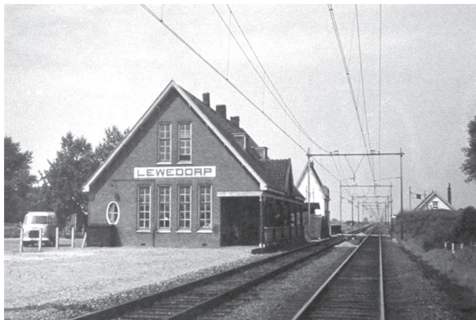
Gezicht vanuit het oosten op het voormalige haltegebouw van Lewedorp (1916-1964) bij km 59,134. Verderop zijn te zien: links dijkcoupure, overweg Toldijk en dienstwoning, en rechts wachterswoning 53. Foto uit circa 1960.
