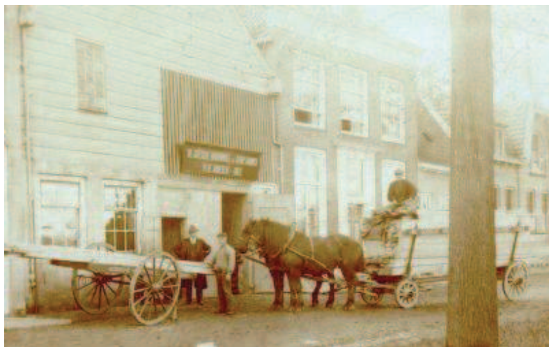
De houthandel van de gebroeders Harinck aan de J.A. van der Goeskade rond 1900
