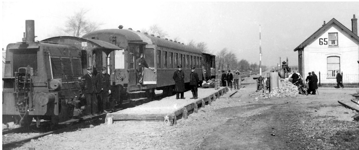
Een locomotor met rijtuig en goederenwagen geeft eind 1944 een eerste mogelijkheid voor het vervoer van arbeiders en stukgoederen uit en naar Souburg. De trein stopt aan het Draaibrugpad (km 72,023 Rsd - Vs) bij wachterswoning 65. Het lijkt erop dat er nogal wat spoorwegpersoneel bij die trein betrokken is. Foto, collectie Gemeentearchief Vlissingen.
