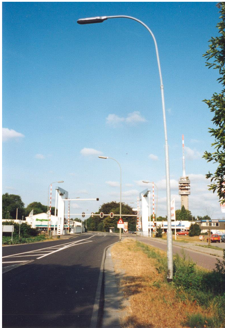
De Ringbrug, gezien in westelijke richting, anno 1995.
