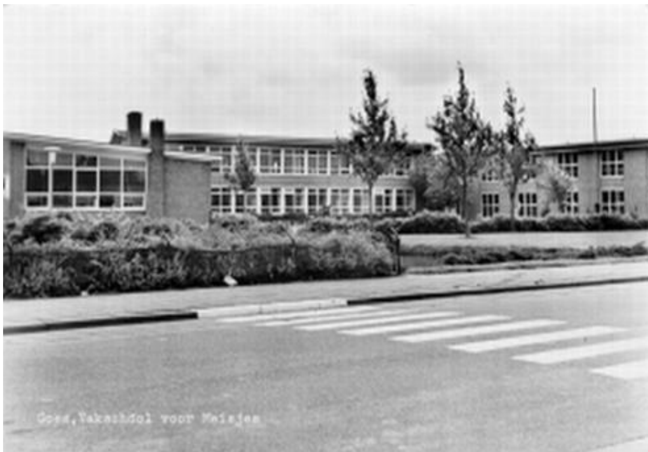
Ook de Vakschool voor Meisjes kreeg de beschikking over een nieuwe schoolgebouw aan de Bergweg; hier een opname van omstreeks 1965. Het complex is enkele jaren geleden gesloopt.
