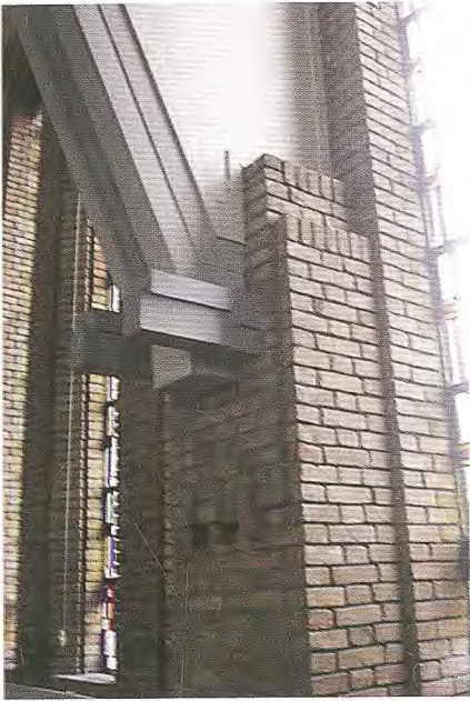
Foto 13. De plaats waar de gevel en de dakconstructie samenkomen.
