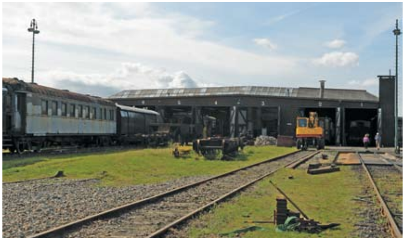
De constructie van het tractiegebouw bevat enkele noviteiten
