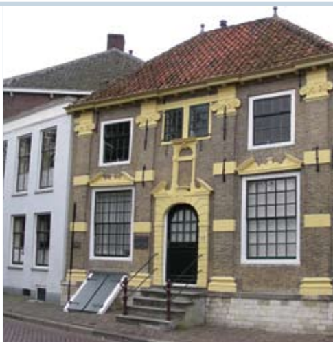
De monumentenstichting is gehuisvest in het Huis Hoop, de voormalige brugwachterswoning
